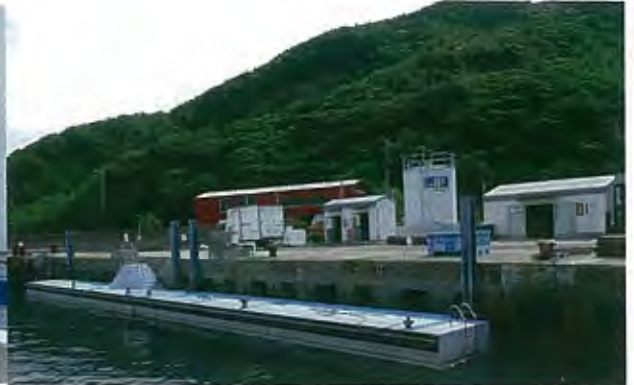
② 自動給油施設 (24H 対応カード式)
