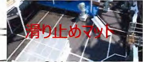
②作業甲板の滑り止めマット設置
