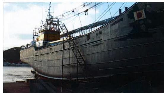
A/C(錆止め)塗装
