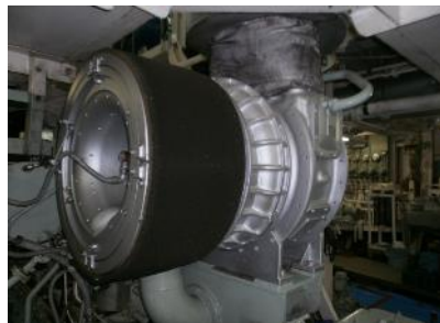
過給機開放清掃
