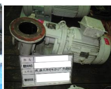
各ポンプ整備
