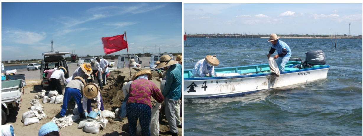
図 3.2.10 砂を土嚢袋に詰める作業（左）と船上からの投入作業（右）
